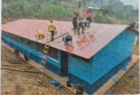
Foto 1: Recubrimiento con anticorrosivo al techo. (renglón II)
