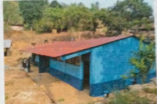
Foto 2: Aplicación de Pintura de Aceite en muros interior y exterior (Renglón I)
