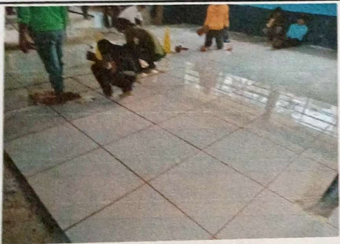
Foto 3: Instalación de Piso cerámico (porcelanato), en el interior del módulo. (Renglón IV)
